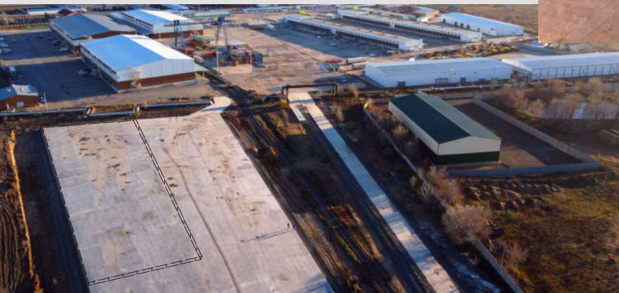
СКЛАД ВРЕМЕННОГО ХРАНЕНИЯ № 3 2700 м 2
