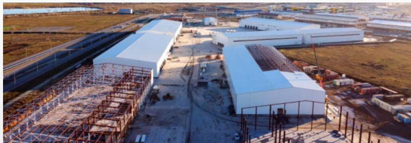
Склады сухого хранения №№ 2, 3, 5, 6, 7, 8 - каждый по 5500 м 2
