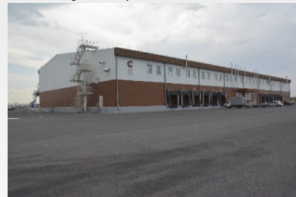
Склад сухого хранения «С» - 6000 м 2
